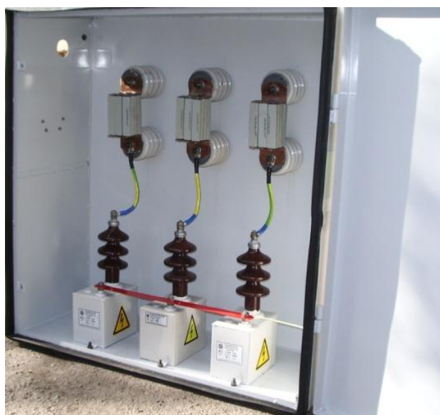
Рисунок 10 – Внешний вид RC-гасителя с выносным блоком сопротивлений
