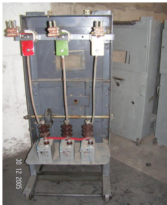
Рисунок 10 – Выкатная тележка с РС-ограничителем
