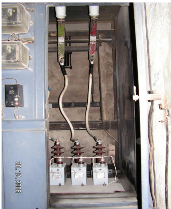
Рисунок 9 – Ячейка РУ с РС – ограничителем
