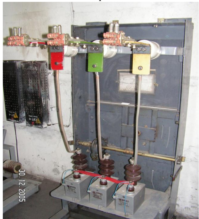
Рисунок П12.4 – Выкатная тележка с RC–ограничителем
