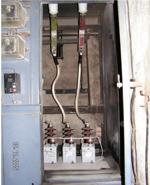
Рисунок П12.1 – Ячейка РУ с RC–ограничителем
