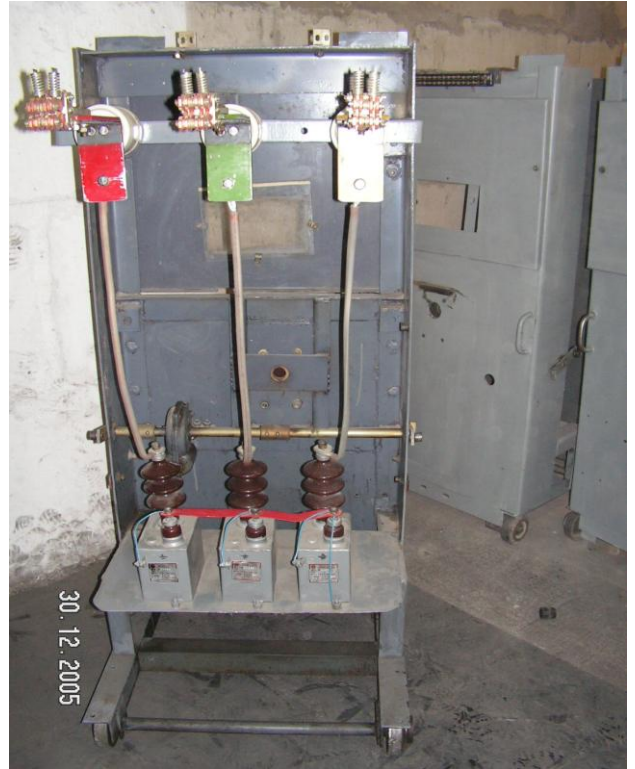
Рисунок П12.2 – Выкатная тележка с RC–ограничителем
