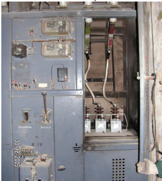
Рисунок П12.3 – Ячейка РУ с RC –ограничителем
