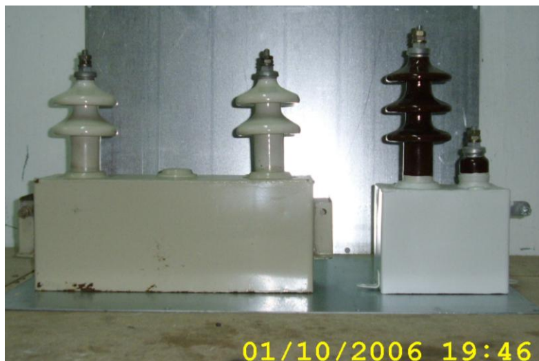
Рисунок П12.7 – Стандартный и RC – ограничитель для УЭН
